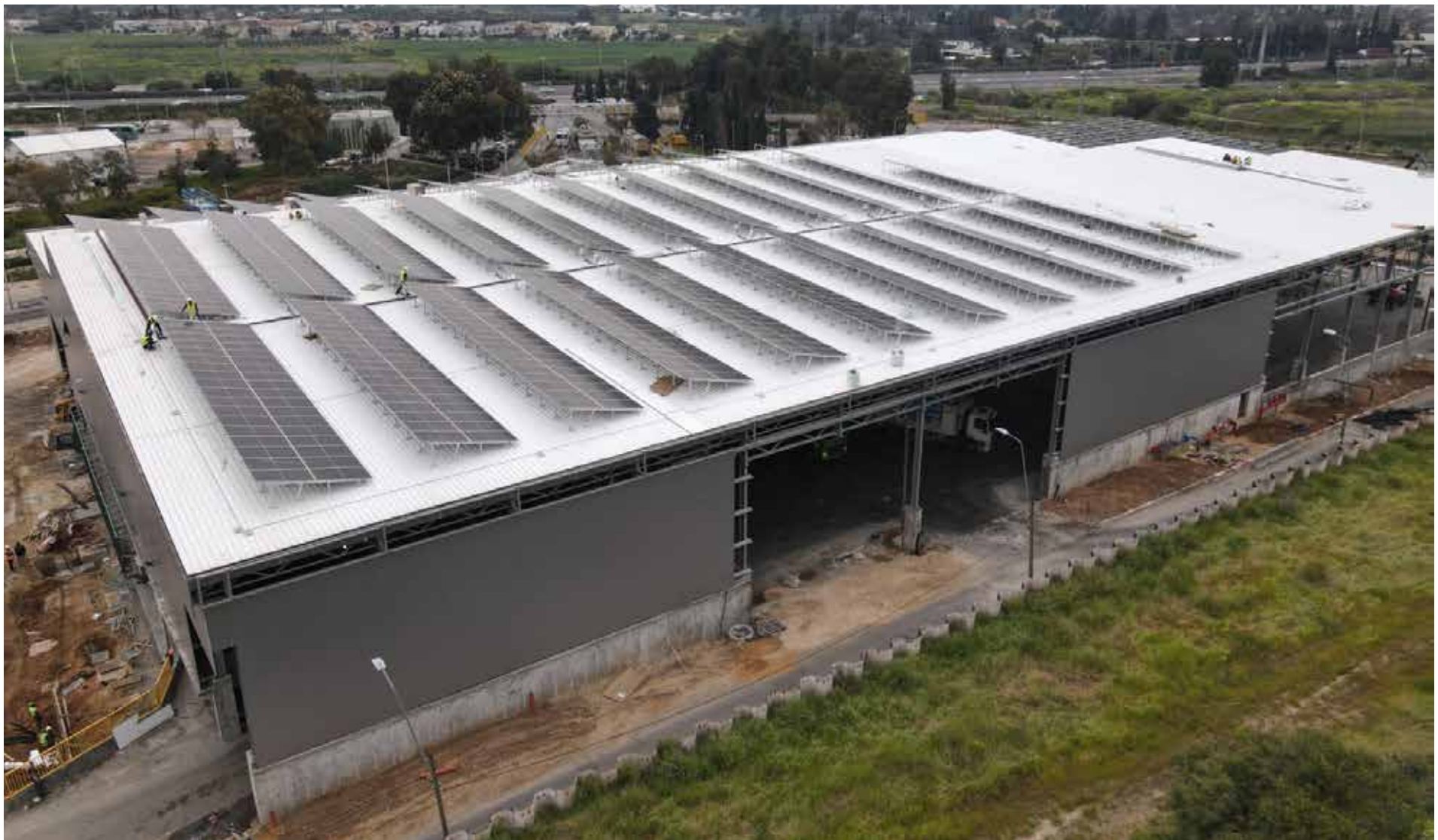
התקנת מערכת סולארית על גג תחנת המעבר המשודרגת והמקורה
